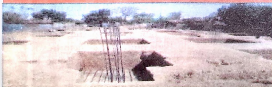
Enfin, le début des travaux de construction P.12
