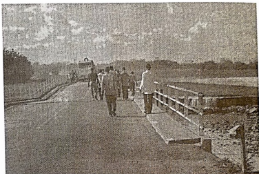
Le pont cassé à liguidimalguem dans le centre Est
