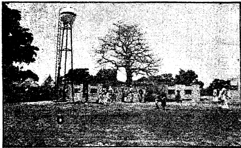
A l'entrée de la concession familiale, le grand château d'eau.
