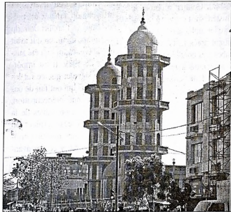
La construction de la medersa centrale a été la deuxième œuvre de la communauté après celle de la grande mosquée.
